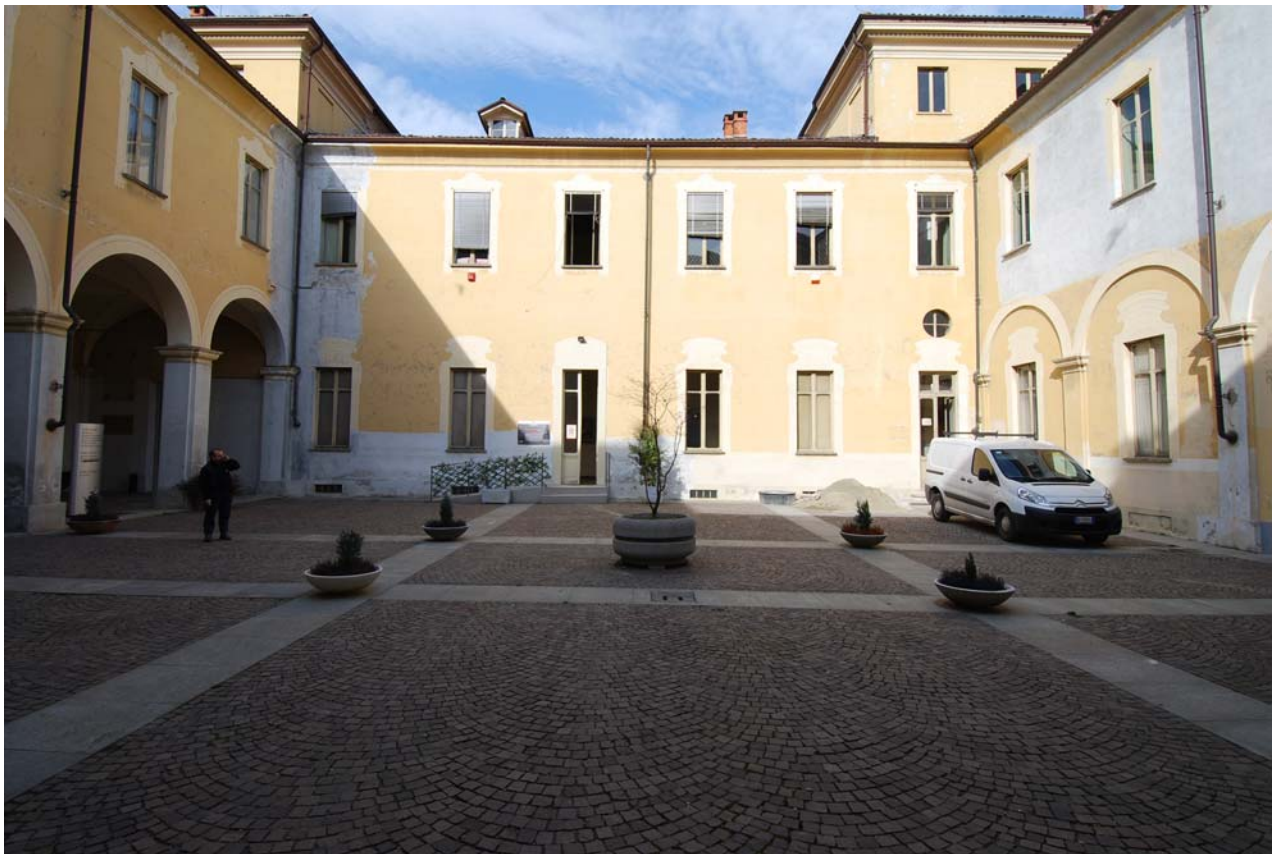
Vista della corte interna
